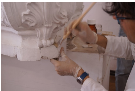
FIG. 13: Consolidación del soporte, utilizando el adhesivo Movithal B60H al 15% en acetona.
