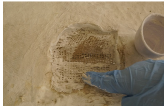
Figura 16. Reconstitución de parte faltante utilizando fibras naturales (yute) e masa de consolidación en yeso rápido e PVA.
